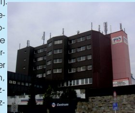
Mobilfunksender auf Wohnhaus
