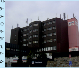
Mobilfunksender auf Wohnhaus
